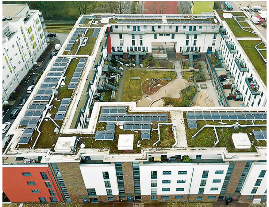
Das Apfel-Carré in Frankfurt mit den installierten Fotovoltaikanlagen.
