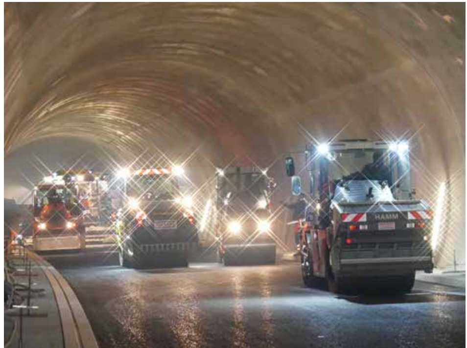
A 44 Asphaltarbeiten im Tunnel Spitzenberg, Bild: DEGES GmbH
