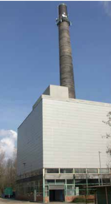
HKW Gießen Außenansicht Bild: Stadtwerke Gießen AG
