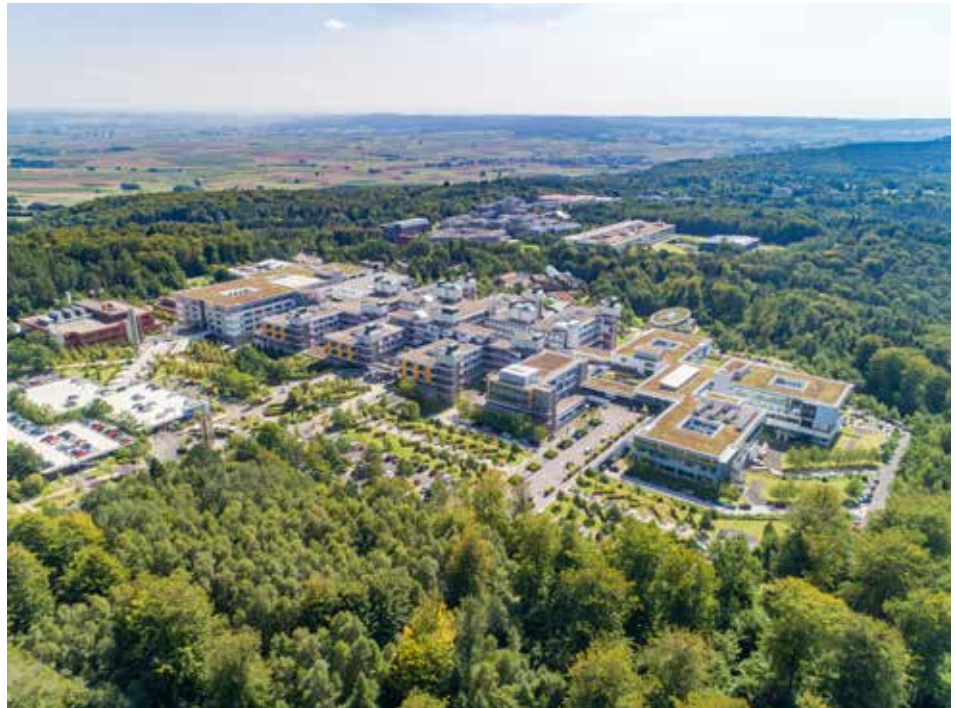
Klinikbauten in Marburg Bild: UKGM GmbH
