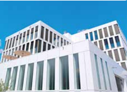
Gebäude der Hessen Agentur Holding, Außenansicht Bild: Dr. Carsten Ott
