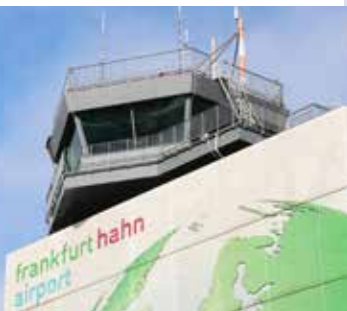
Tower Flughafen Frankfurt-Hahn, Bild: Flughafen Frankfurt-Hahn GmbH
