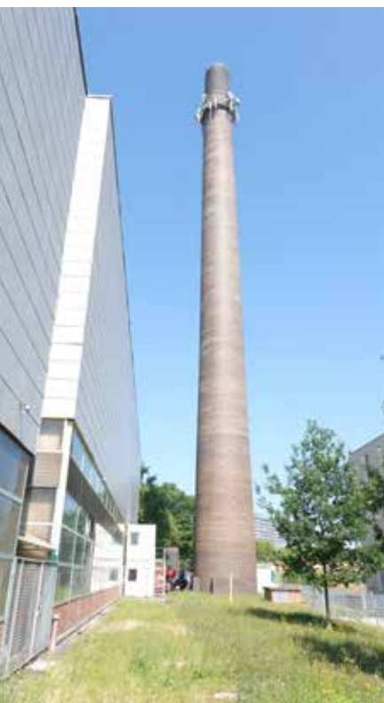
HKW Gießen Außenansicht Bild: Stadtwerke Gießen AG
