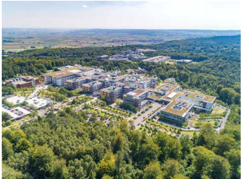
Klinikbauten in Marburg Bild: UKGM GmbH
