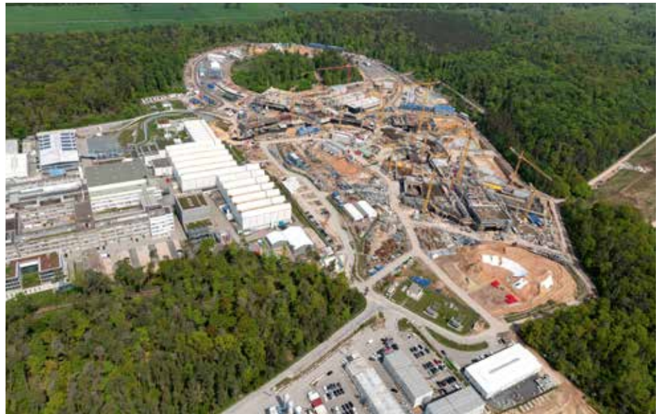
Die FAIR-Baustelle aus der Luft, Bild: D. Fehrenz/GSI/FAIR
