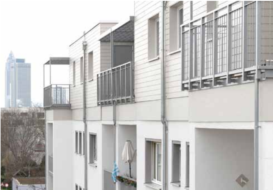
Aufstockung der Fritz-Kissel Siedlung, Frankfurt a. Main, Bild: NHW, Marc Strohfeldd
