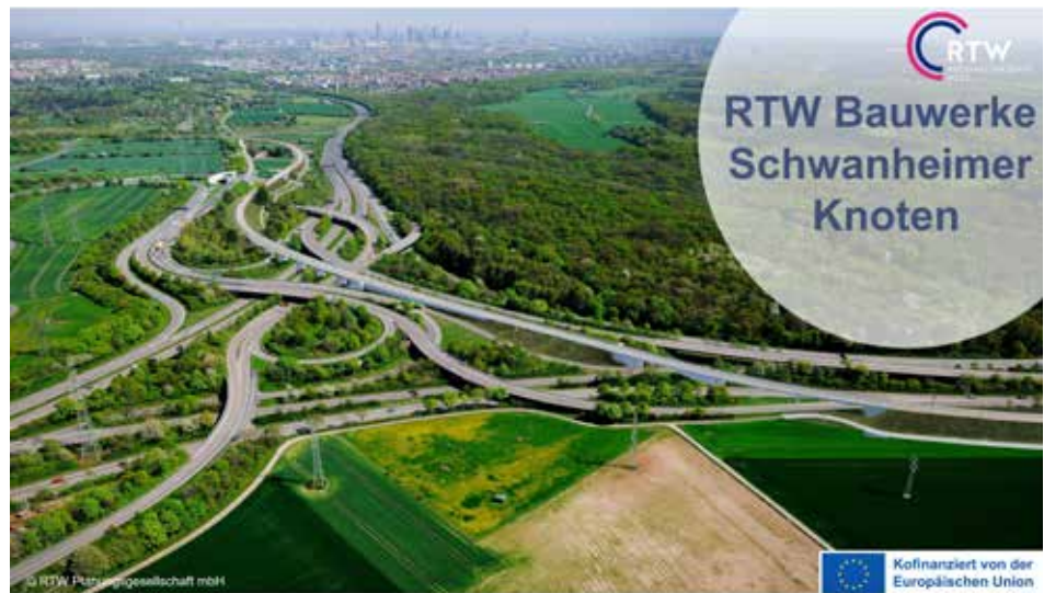
RTW-Bauwerke Schwanheimer Knoten, Bild: RTW GmbH
